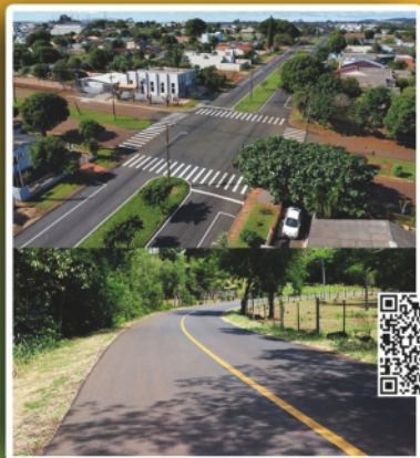
Mais ASFALTO na cidade e no campo
